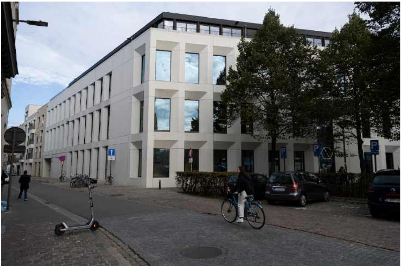
Het dakterras op dit gebouw wordt het zomerse speelveld van cultuurhuis De Studio. © Klaas De Scheirder
